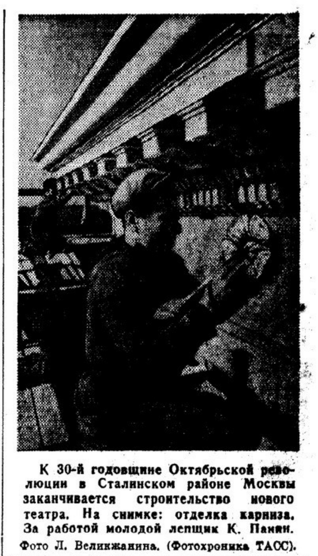
К 30-й годовщине Октябрьской революции в Сталинском районе Москвы заканчивается строительство нового театра. На снимке: отделка карниза. За работой молодой лепщик К. Панин. Фото Л. Величкина. (Фотохроника ТАСС).
